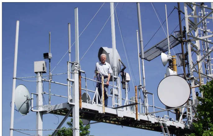
Antennenbrücke auf der 793 m hohen Lausche, Ostsachsen; die Brücke entstand damals, um die Antennen 4 m anzuheben, und diente gleichzeitig als Diebstahl- und Randalierschutz. Zurzeit nutzen Mobilfunkanbieter, die Telekom sowie Funkamateure (ATV- und FM-Relaisfunkstelle DB0LAU, hier DM2CFL bei Antennenarbeiten) die Brücke.
