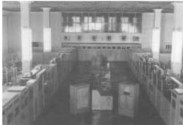
Abb. 11: Sendergebäude, Sendersaal, rechts und links je ein 250-kW-Mittelwellensender, aus: Hermann 1994, *Entwicklung*, S. 165.
